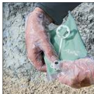
Automatisches und sauberes Öffnen des Gießharzbeutels durch Anbringen des Einfüllstutzens.
