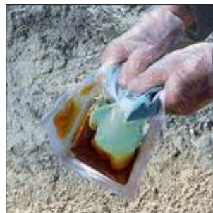
Mit Druck öffnet sich die Trennung zwischen der Gießharz- und Härterkammer.
