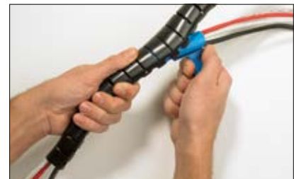
Helawrap wird nun nach dem Reißverschlussprinzip montiert.
