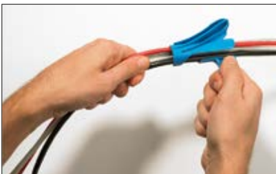
Kabelbündel seitlich in das Aufziehwerkzeug legen.
