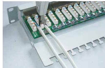
LSA-Kontakte mit Einlegewerkzeug auflegen Punch down wires with LSA-tool.
