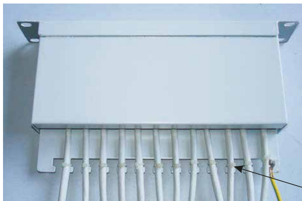
Installierte Kabel mit Kabelbindern zugentlasten Fasten cable ties for additional strain relief.
