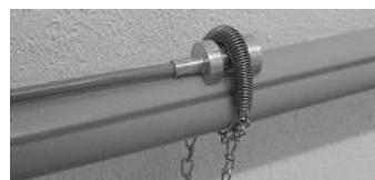
**Attention !** Lors du montage, veillez à ce que le ressort ne risque pas de sauter car il pourrait blesser quelqu'un aux yeux. Si les tuyaux sont gainés avec un matériau isolant, retirez ce matériau à l'emplacement prévu pour la sonde ou placez la sonde thermique au-dessous de la gaine.
