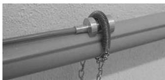
**Achtung!** Achten Sie bei der Montage darauf, dass die Feder nicht weg springen kann, da dies zu Augenverletzungen führen kann. Sollten die Rohre von Dämmmaterial umgeben sein, entfernen Sie an der vorgesehenen Stelle dieses Material oder montieren Sie die Temperatursensor darunter.
