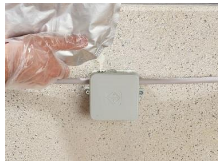
6. ISO FLEX Gel aus dem Beutel in den geschlossenen Abzweigkasten einfüllen.
