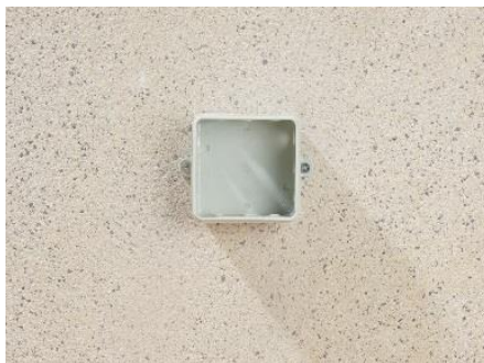
1. Montage des Abzweigkastens.
