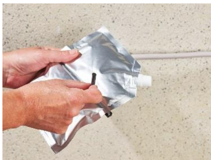
3. Vorbereiten des ISO FLEX Gel durch Herausziehen der Feuchtigkeitssperre, die den Beutel in zwei Kammern unterteilt.
