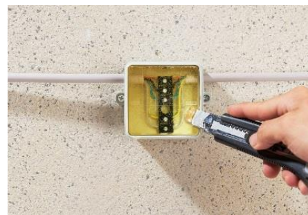
9. Bei Bedarf kann das ISO FLEX Gel wieder aus dem Abzweigkasten entfernt werden
