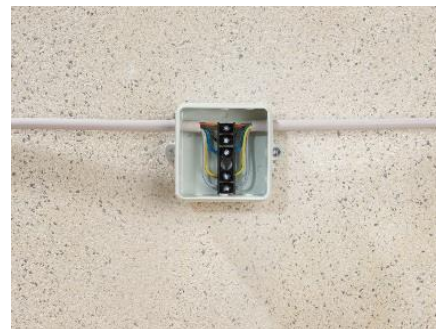
2. Verlegung und Verdrahtung der Kabel. Anschließend Abzweigkasten bis auf das Einfüllloch schließen!
