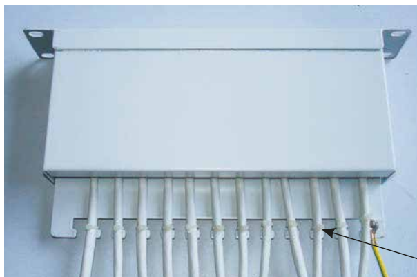
Installierte Kabel mit Kabelbindern zugentlasten Fasten cable ties for additional strain relief.
